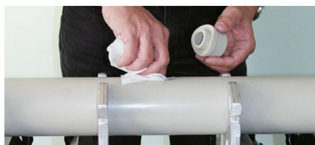
2/ Začistíme otvor a odmastíme tvarovku i vyvrtaný otvor.
