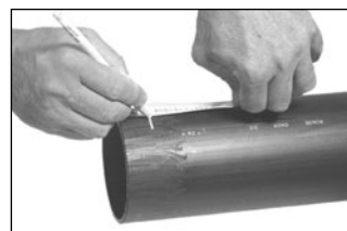
Označení požadované zásuvné délky
