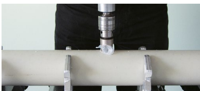
1/ Speciálním vrtákem vyvrtáme otvor pro potrubí.
