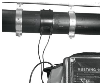
Svařování pomocí elektroodporového nátrubku
