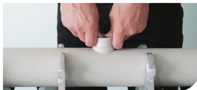
4/ Nahřáté sedlo nasuneme do nahřátého otvoru a fixujeme. Po uplynutí jedné hodiny lze napustit vodou a namáhat tlakem.
