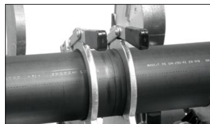
Správně připravené potrubí ke svařování
