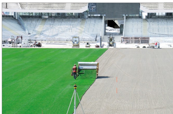
Obr. 11-71 Pokládka trávníku
