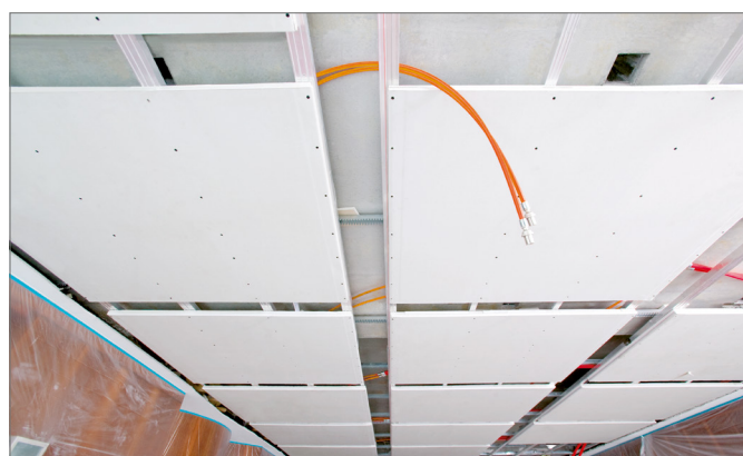
Obr. 6-7 REHAU systém stropního vytápění / chlazení - suchý způsob
