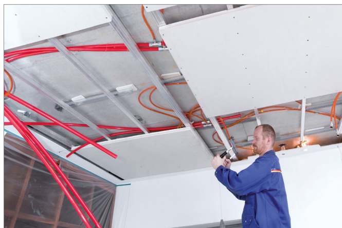
Obr. 6-24 Propojení připojovacího potrubí
