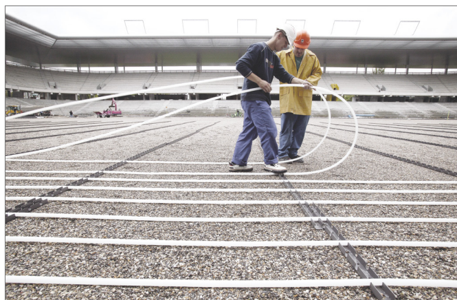
Obr. 11-70 Pokládka topných trubek
