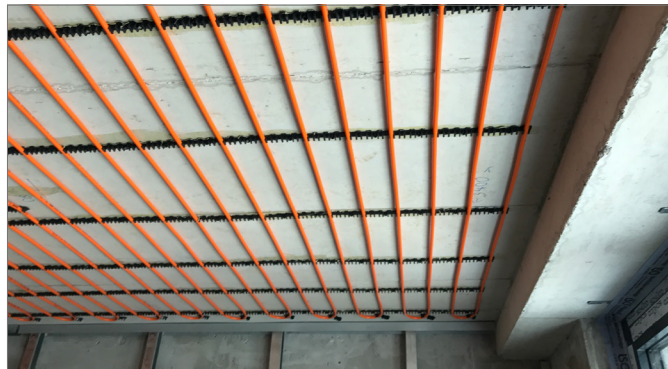
Obr. 6-32 REHAU systém stropní vytápění / chlazení - mokrý způsob
