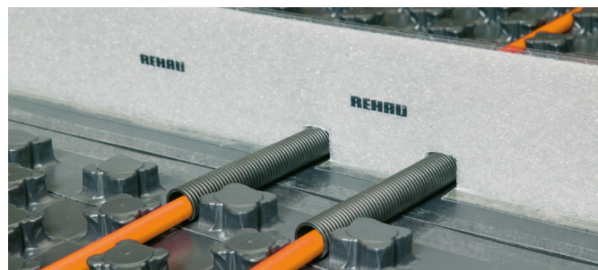
Obr. 4-150 Dilatační profil na systémové desce Varionova
