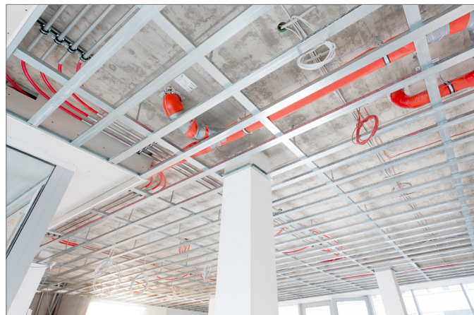
Obr. 6-22 Připravená konstrukce podhledu
