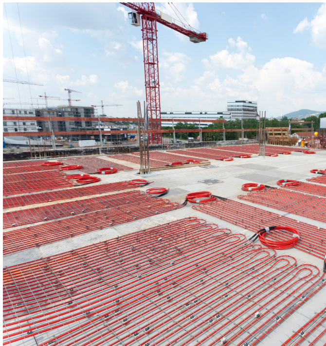
oBKT / BKT temperování nosných betonových konstrukcí
