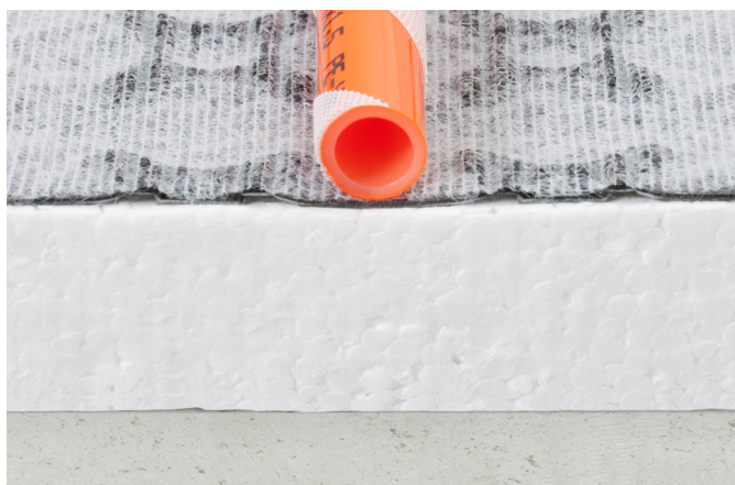
Obr. 4-47 Konstrukce podlahy tepelnou a kročejovou izolací
