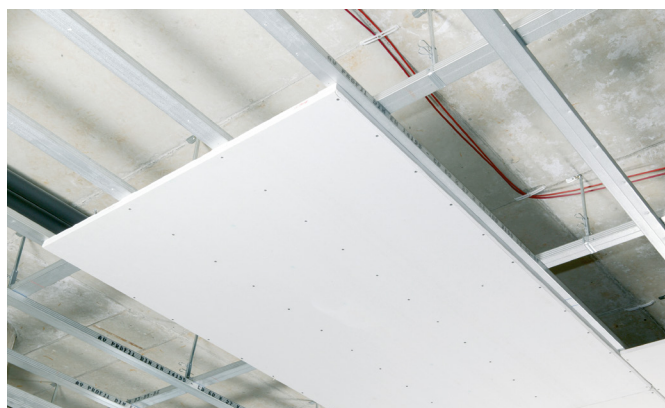
Obr. 6-14 Namontovaná stropní deska
