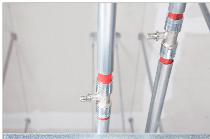
Obr. 6-23 Připravené T-kusy pro napojení stropních desek
