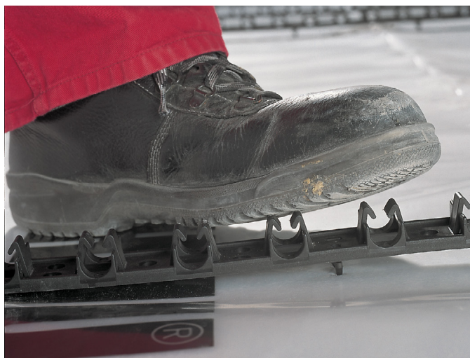
Obr. 4-121 Zatláče vodící lištu RAUFIX do podlahové konstrukce
